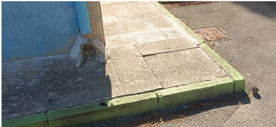
Area esterna "zona infanzia"
