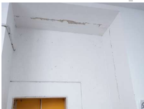
Vano ascensore pad.A piano primo
